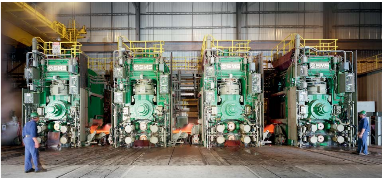
Bild 8. Viergerüstige CSP®-Anlage bei Nucor Crawfordsville.
