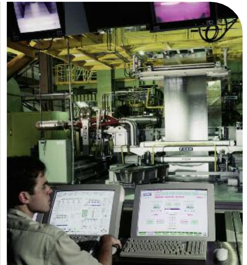
Steuerstand in einer Konti-Beizanlage
