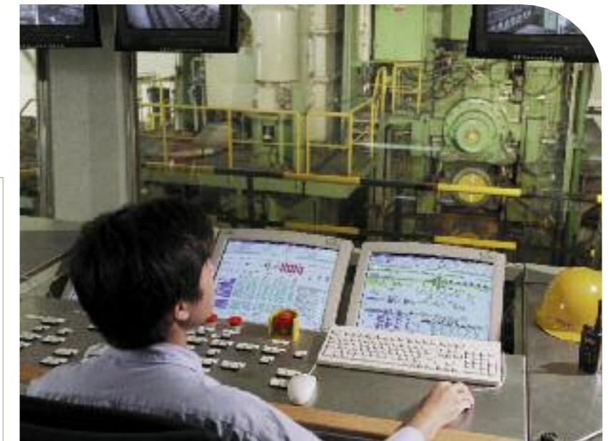
Steuerstand eines Warmwalzwerkes
